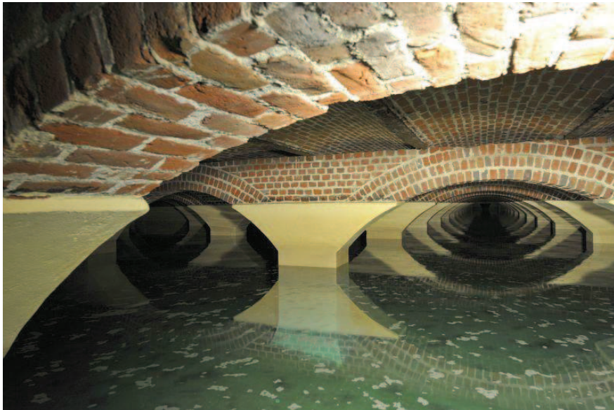
Vue intérieure du réservoir de Mouvaux
