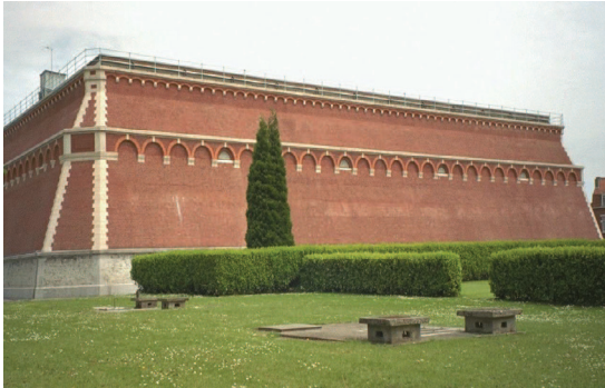
Réservoir au sol de Mouvaux
