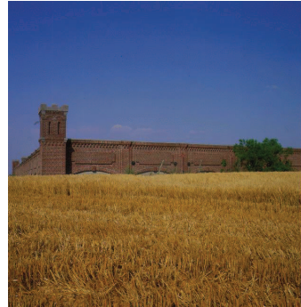
Réservoir au sol de Mons
