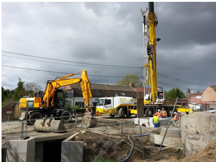
Photo présentant la mise en œuvre du déversoir d'orage
