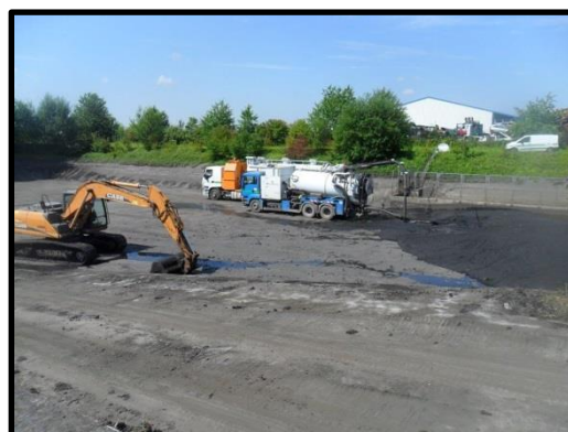
Photo illustrant le curage d'un bassin
