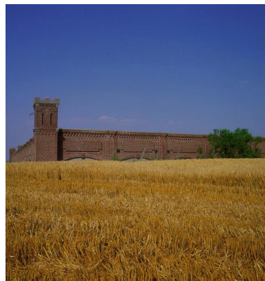
Réservoir au sol de Mons
