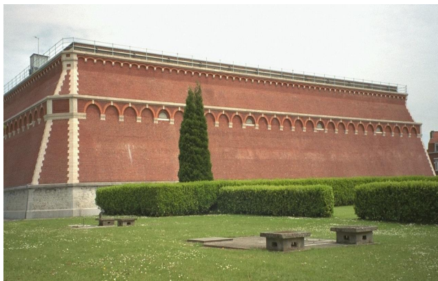
Réservoir au sol de Mouvaux
