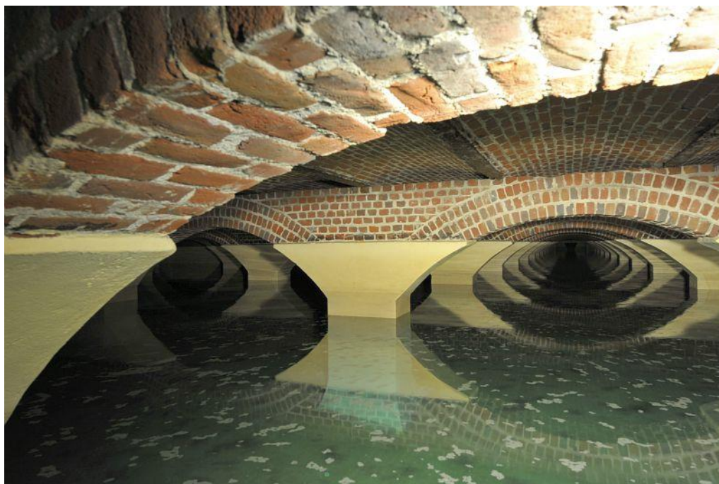
Vue intérieure du réservoir de Mouvaux
