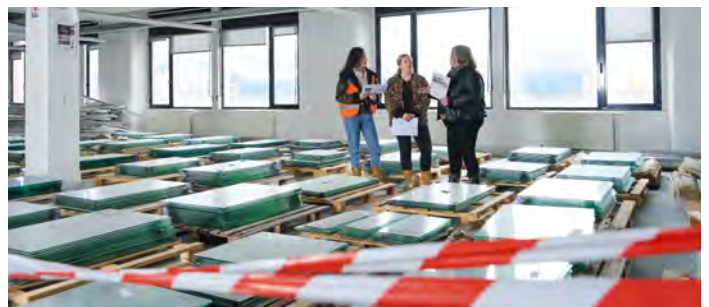
A Blanchemaille à Roubaix, une matériauuthèque a été constituée suite à la dépose soignée, dans le cadre de la réhabilitation du lieu. Ces matériaux seront ré-employés dans la suite du chantier.
