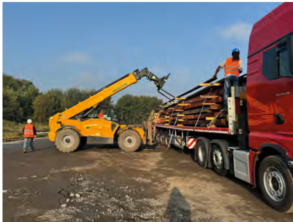
La charpente métallique d'un ancien entrepôt à Bousbecque récupérée pour la structure du futur siège de Ville Renouvelée.
